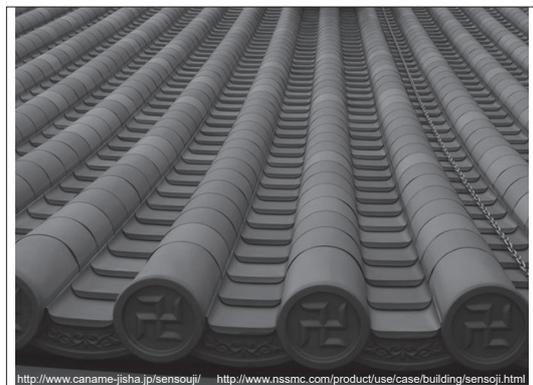
多くの方々は、この写真がどうしてレアメタルの話につながるのだ？と思われる方も多いでしょうが、この瓦は、実はすべてチタン製です。昔は、重たい素焼きの陶器の瓦が使われていましたが、地震があると落下して危険ですし、重たい下の瓦は木造建築への負荷が大きくなります。そこで、今は、0.3 mm くらいの薄いチタン製の板が瓦として使われています。しかし、チタンで瓦をつくると均一な色のものができてしまうので、一般の人には、すぐに、素焼きの陶器でないことがわかってしまいます。そこで、わざと素焼きのような焼きムラをつけて、チタン板の色を陶器の瓦のように変化させているのです。
