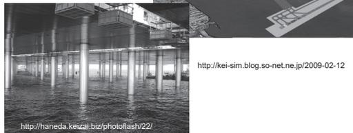
すね、海上滑走路を支えている柱の部分は、耐候性のステンレス鋼が使われているようです。チタンは、錆びると困るところ、ロングライフの（超寿命が要求される）ところ、軽くて強度が必要なところ、などに使われています。
